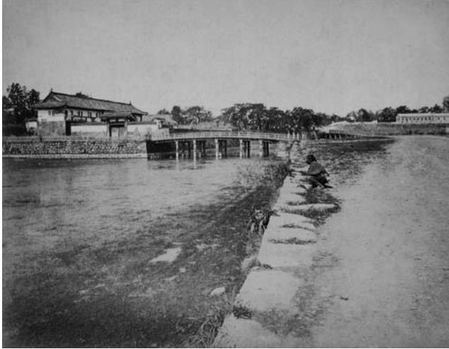
写真1 東京竹橋の遠景
