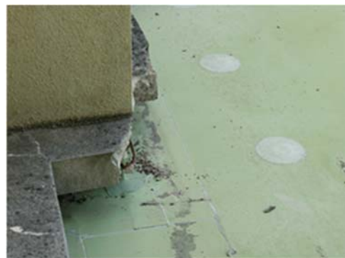
Photo.4 大村市竹松小学校
